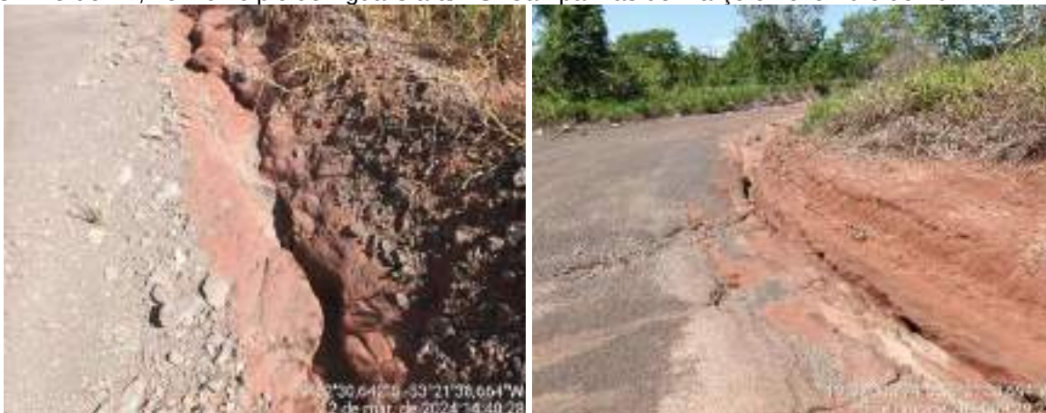
Figura 5 – Ponto 3: Erosão em sulcos na margem da estrada de acesso ao reservatório, área 1 da PCH Verde 4A, no município de Água Clara/MS. Campanhas de março e novembro de 2024.
