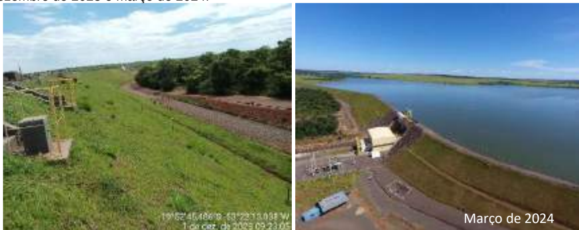
Figura 8 – Taludes da PCH Verde 4A, evidenciando área cascalhada e gramada. Campanha de dezembro de 2023 e março de 2024.
