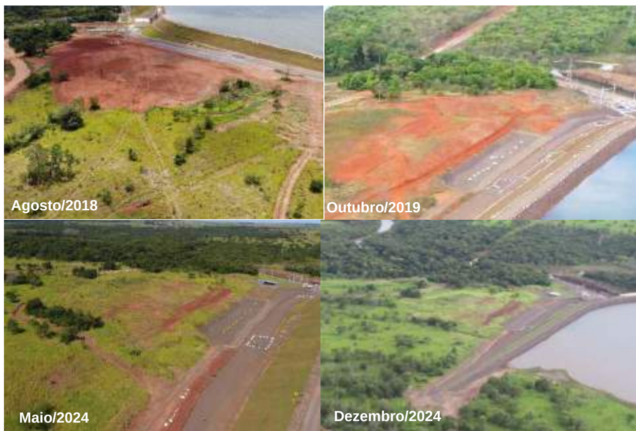
Figura 6 - Imagem aérea Área de bota-fora.
