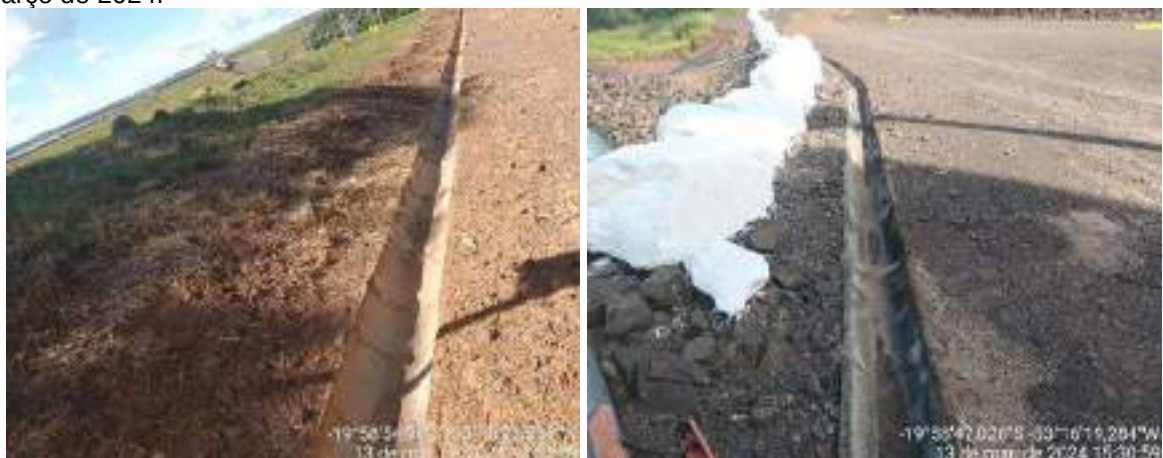
Figura 15. Caneletas de escoamento da PCH Verde 4; Município de Água Clara/MS. Campanha de março de 2024.
