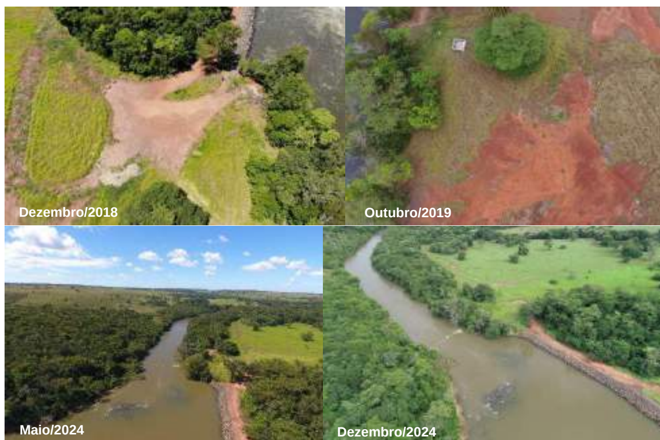
Figura 7 – Imagens da aérea da antiga Área de Captação de água à jusante do barramento.
