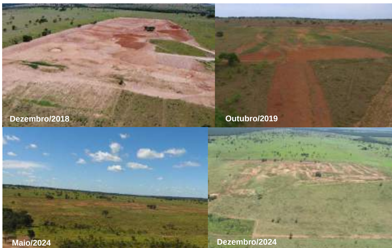
Figura 5 – Imagens da aérea da antiga Área de Empréstimo de Argila.
