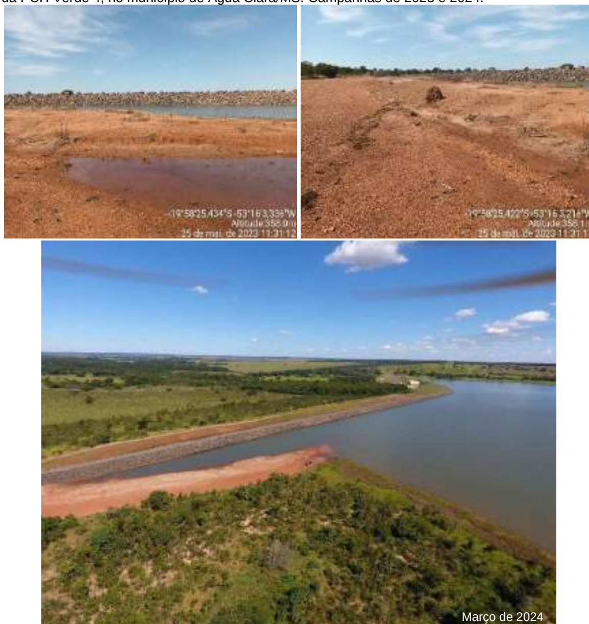
Figura 3. Ponto 1: Marcas de erosão em sulcos na margem, ausência de cascalho ou vegetação, área 1 da PCH Verde 4, no município de Água Clara/MS. Campanhas de 2023 e 2024.
