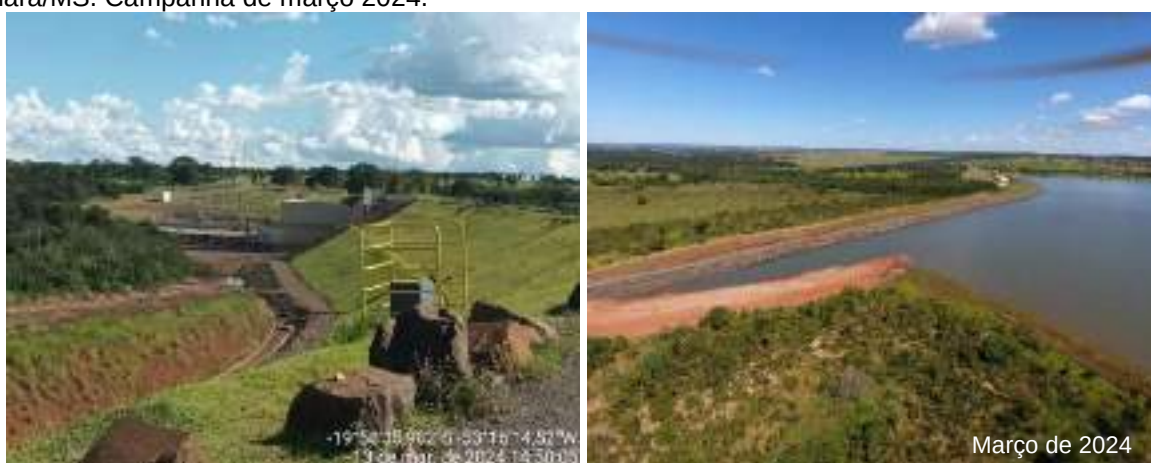
Figura 13. Taludes da PCH Verde 4, contendo área cascalhada e gramada. Município de Água Clara/MS. Campanha de março 2024.
