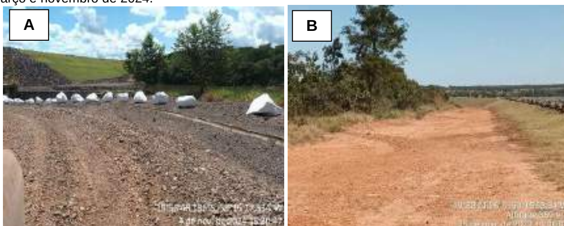
Figura 14. Estradas de acesso interno da PCH Verde 4 em estado apropriado: (A) acesso a casa de força; (B) acesso a margem esquerda da jusante; (C) acesso ao barramento; (D) acesso a guarita e portão; (E) acesso a subestação; (F) Talude a jusante. Município de Água Clara/MS. Campanhas de março e novembro de 2024.
