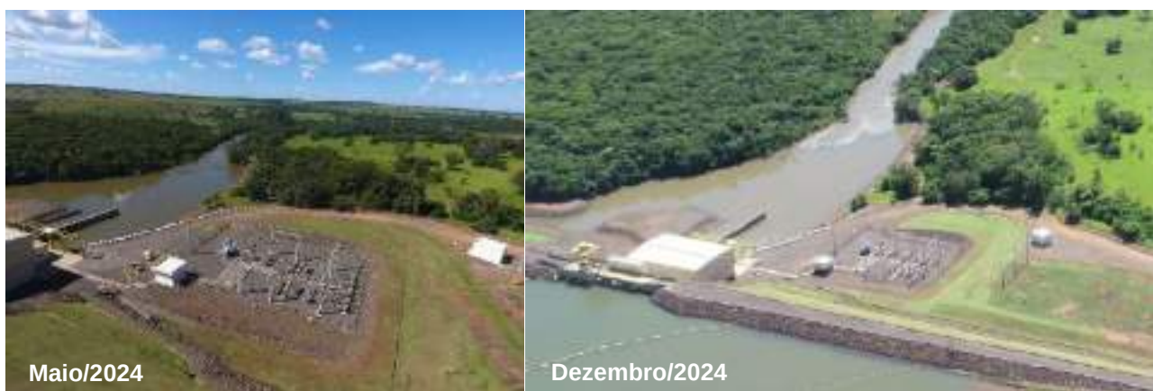
Figura 6 – Imagens da aérea da antiga Área do Escritórios de apoio próximo a subestação.
