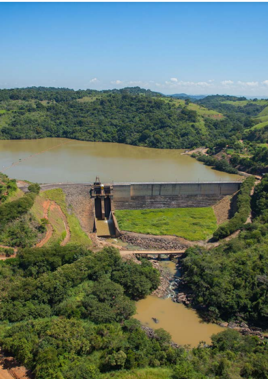
Hidrelétrica Ivan Botelho I
