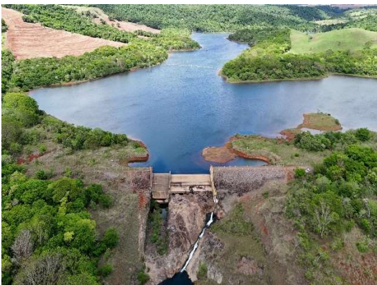
Figura 103 - Vista aérea do reservatório sem presença de estande de macrófitas. Fonte: Cedro Inteligência Ambiental, Out/2024.
