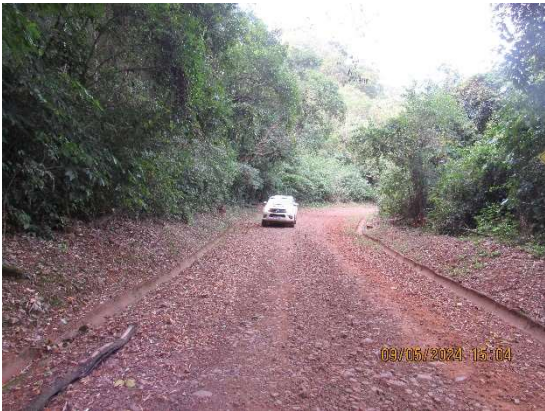
Figura 35 - Sistema de drenagem em ambos os lados da via de acesso. Fonte: Cedro Inteligência Ambiental, Maio/2024.
