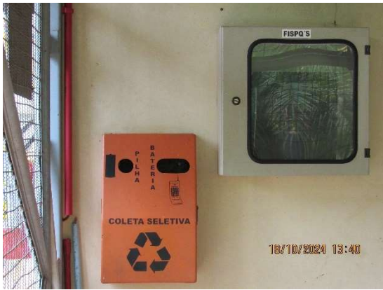
Figura 16 - FISPQ's do depósito de contaminantes. Fonte: Cedro Inteligência Ambiental, Out/2024.
