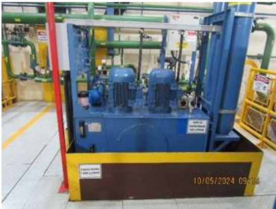
Figura 20 - UHRV da Galeria Mecânica. Fonte: Cedro Inteligência Ambiental, Mai/2024.
