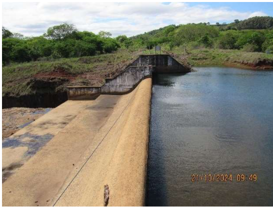
Figura 112 - Vista do barramento do reservatório sem presença de estande de macrófitas. Fonte: Cedro Inteligência Ambiental, Out/2024.
