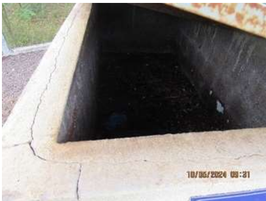
Figura 47 - Depósito de compostagem e horta Fonte: Cedro Inteligência Ambiental, Maio/2024.
