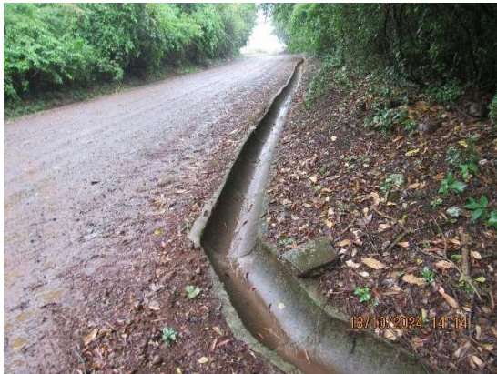
Figura 36 - Sistema de drenagem devidamente instalado em via de acesso. Fonte: Cedro Inteligência Ambiental, Out/2024.
