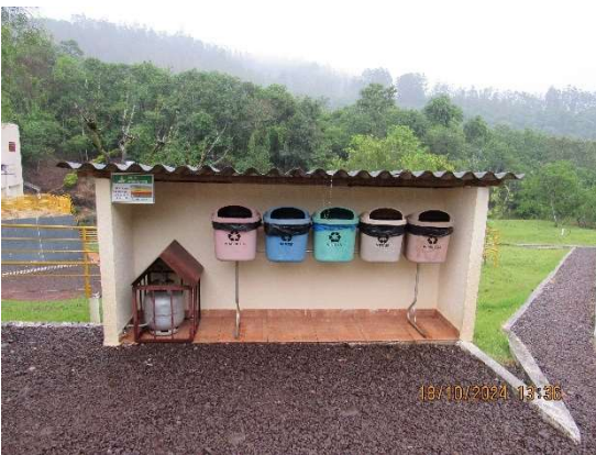
Figura 8 - Lixeiras seletivas na área de TDA de Alta e Baixa Pressão. Fonte: Cedro Inteligência Ambiental, Out/2024.
