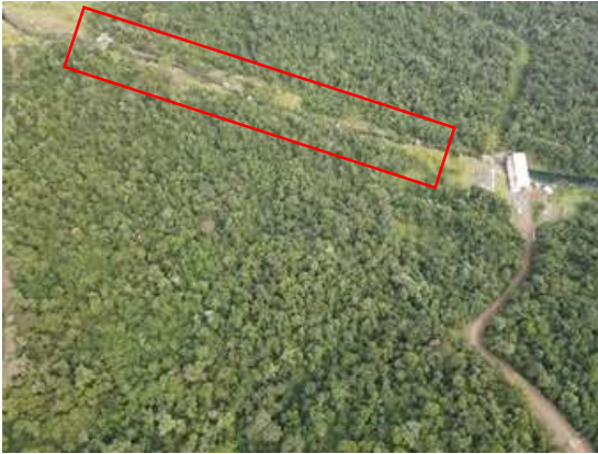
Figura 81 - Vegetação no entorno do conduto forçado. Fonte. Cedro Inteligência Ambiental, Maio/2024.
