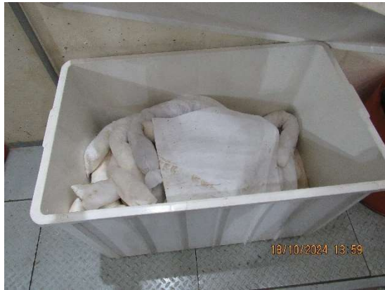
Figura 28 - Kit de mantas e cordões absorventes na área interna da subestação. Fonte: Cedro Inteligência Ambiental, Out/2024.
