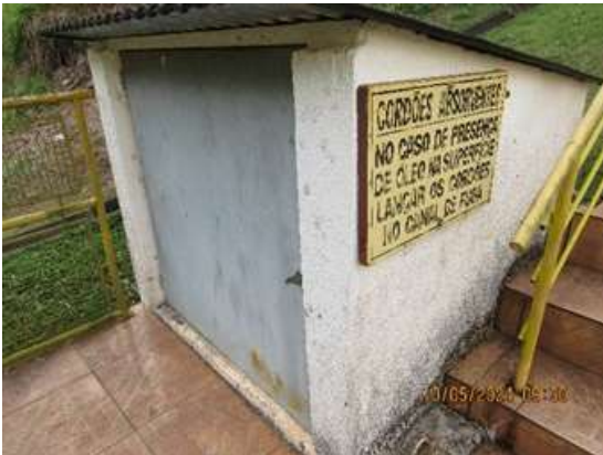
Figura 31 - Kit para derramamento de óleo, na área externa da usina. Fonte: Cedro Inteligência Ambiental, Maio/2024.
