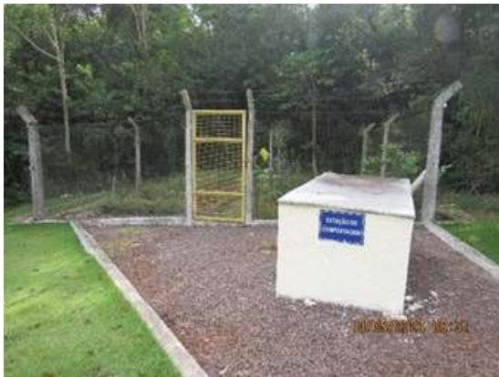
Figura 45 - Depósito de compostagem e horta Fonte: Cedro Inteligência Ambiental, Maio/2024.
