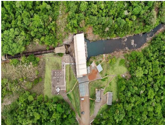
Figura 84 - Vegetação próxima a casa de força. Fonte: Cedro Inteligência Ambiental, Out/2024.
