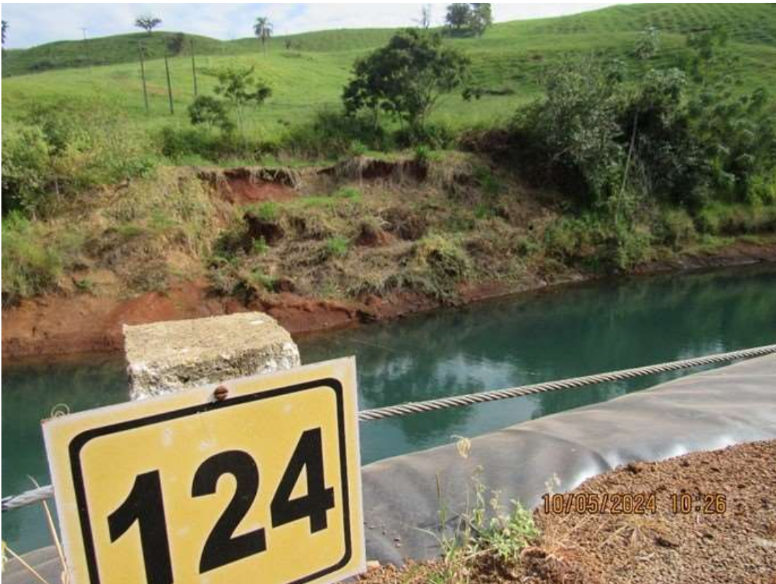
Figura 71 - Aspecto do ponto P7. Fonte: Cedro Inteligência Ambiental, Maio/2024.
