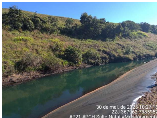
Figura 121 - Aspecto do ponto P21. Fonte: Cedro Inteligência Ambiental, maio/2025.
