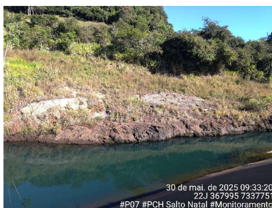
Figura 96 - Aspecto do ponto P07. Fonte: Cedro Inteligência Ambiental, maio/2025.
