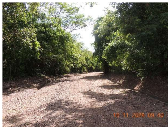
Figura 42 - Sistema de drenagem devidamente instalado em via de acesso. Fonte: Cedro Inteligência Ambiental, nov./2025.
