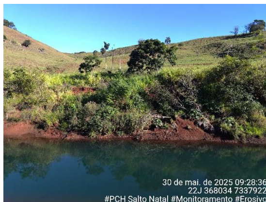
Figura 92 - Aspecto do ponto P06. Fonte: Cedro Inteligência Ambiental, maio/2025.
