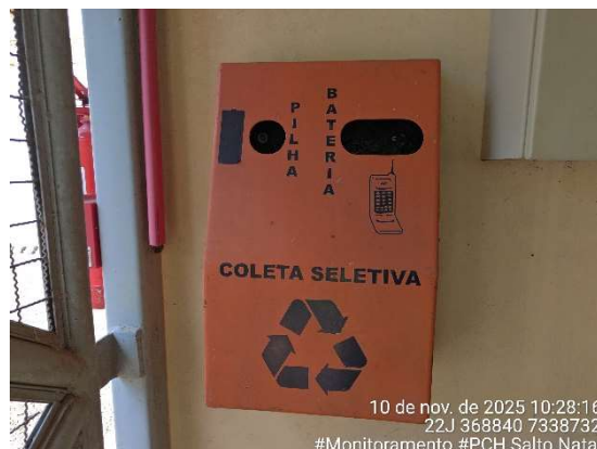
Figura 12 - Contendor coleta de pilhas e baterias. Fonte: Cedro Inteligência Ambiental, nov./2025.
