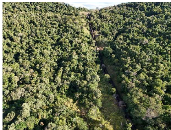
Figura 143 - Vegetação no entorno do conduto forçado. Fonte: Cedro Inteligência Ambiental, maio/2025.
