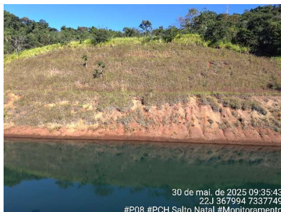
Figura 100 - Aspecto do ponto P08. Fonte: Cedro Inteligência Ambiental, maio/2025.
