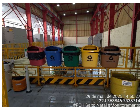
Figura 3 - Contentores seletivos na área de montagem. Fonte: Cedro Inteligência Ambiental, maio/2025.
