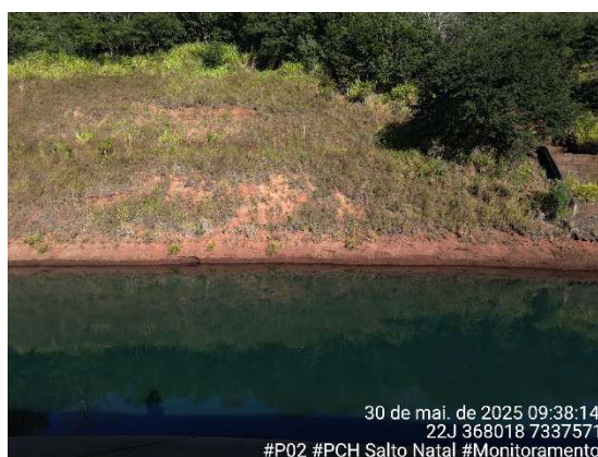
Figura 84 - Aspecto do ponto P02. Fonte: Cedro Inteligência Ambiental, maio/2025.
