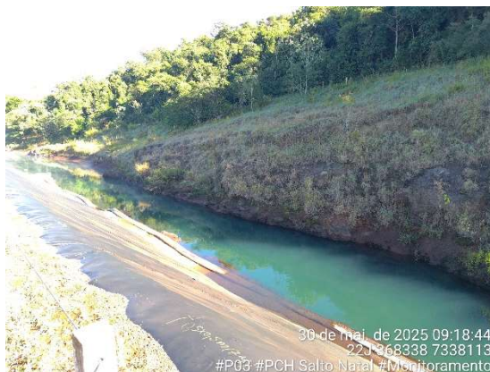
Figura 88 - Aspecto do ponto P03. Fonte: Cedro Inteligência Ambiental, maio/2025.
