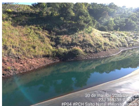
Figura 131 - Aspecto do ponto P04. Fonte: Cedro Inteligência Ambiental, maio/2025.
