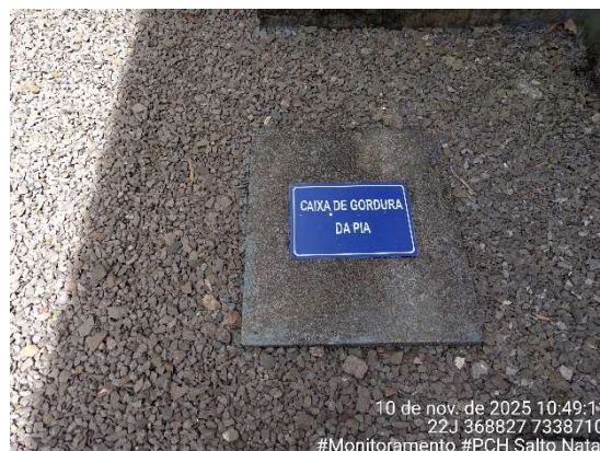
Figura 52 - Caixa de efluentes e caixa de gordura para tratamento primário de efluentes. Fonte: Cedro Inteligência Ambiental, nov./2025.
