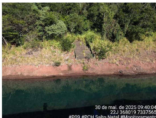
Figura 104 - Aspecto do ponto P09. Fonte: Cedro Inteligência Ambiental, maio/2025.
