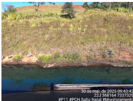
Figura 134 - Aspecto do ponto P11. Fonte: Cedro Inteligência Ambiental, maio/2025.
