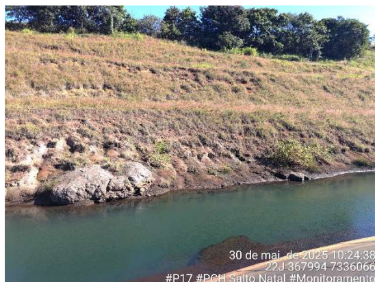
Figura 112 - Aspecto do ponto P17. Fonte: Cedro Inteligência Ambiental, maio/2025.
