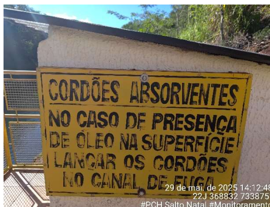
Figura 39 - Kit para derramamento de óleo, na área externa da usina. Fonte: Cedro Inteligência Ambiental, maio/2025.
