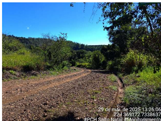
Figura 41 - Sistema de drenagem devidamente instalado em via de acesso. Fonte: Cedro Inteligência Ambiental, maio/2025.
