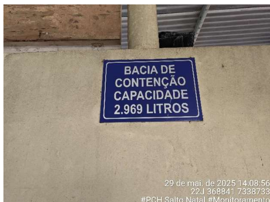
Figura 19 - Indicação da capacidade máxima da bacia de contenção do depósito de contaminantes. Fonte: Cedro Inteligência Ambiental, maio/2025.
