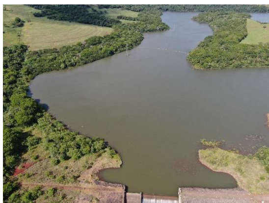
Figura 201 - Aspecto geral aéreo das áreas de APP do reservatório. Fonte: Cedro Inteligência Ambiental, nov./2025.
