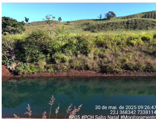
Figura 132 - Aspecto do ponto P05. Fonte: Cedro Inteligência Ambiental, maio/2025.
