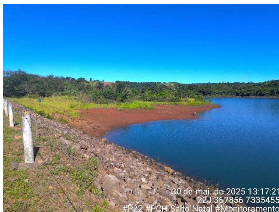
Figura 124 - Aspecto do ponto P22. Fonte: Cedro Inteligência Ambiental, maio/2025.
