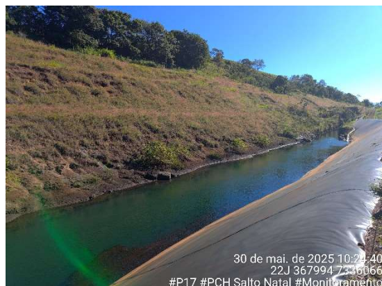
Figura 113 - Aspecto do ponto P17. Fonte: Cedro Inteligência Ambiental, maio/2025.
