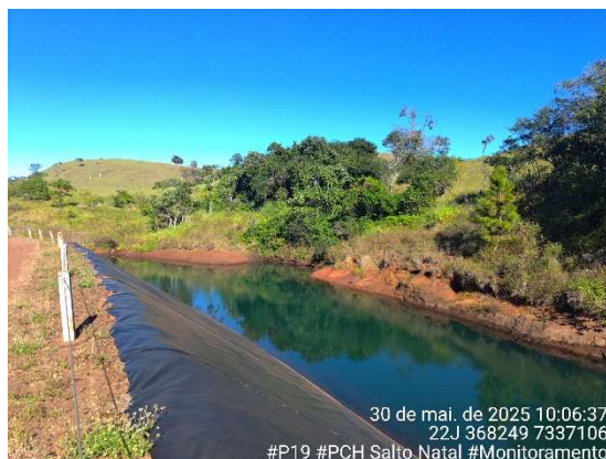
Figura 116 - Aspecto do ponto P19. Fonte: Cedro Inteligência Ambiental, maio/2025.
