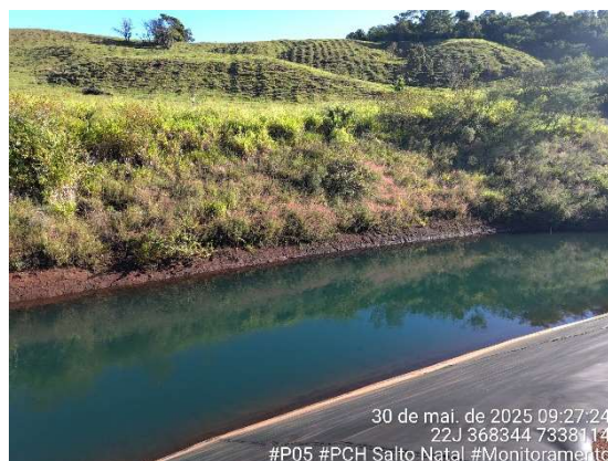
Figura 133 - Aspecto do ponto P05. Fonte: Cedro Inteligência Ambiental, maio/2025.
