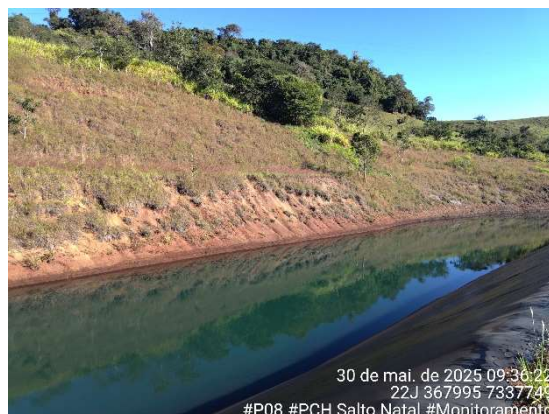
Figura 101 - Aspecto do ponto P08. Fonte: Cedro Inteligência Ambiental, maio/2025.
