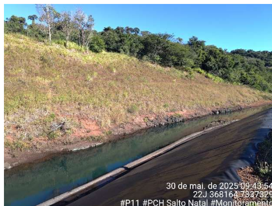
Figura 135 - Aspecto do ponto P11. Fonte: Cedro Inteligência Ambiental, maio/2025.
