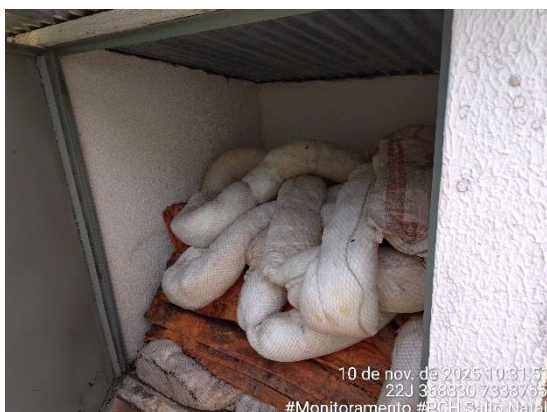
Figura 40 - Kit para derramamento de óleo, na área externa da usina. Fonte: Cedro Inteligência Ambiental, nov./2025.
