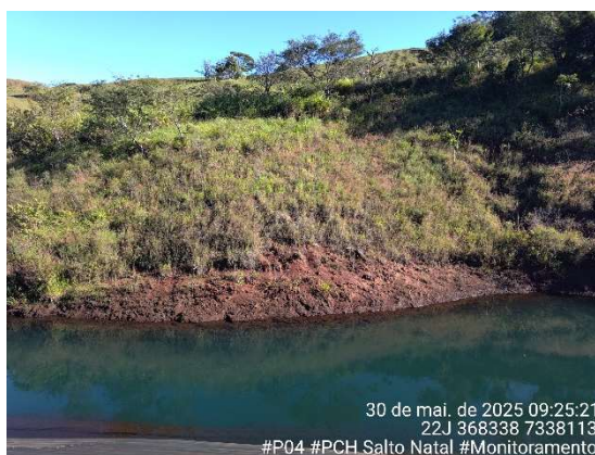
Figura 130 - Aspecto do ponto P04. Fonte: Cedro Inteligência Ambiental, maio/2025.
