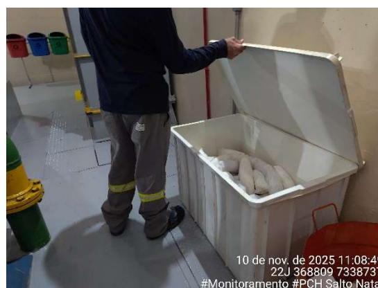
Figura 34 - Kit de mantas e cordões na galeria mecânica. Fonte: Cedro Inteligência Ambiental, nov./2025.
