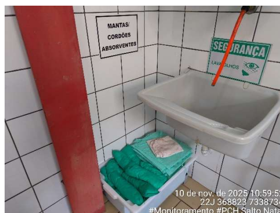
Figura 36 - Kit de mantas e cordões absorventes e lava olhos na área interna na sala de baterias. Fonte: Cedro Inteligência Ambiental, nov./2025.
