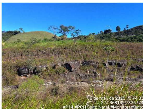
Figura 136 - Aspecto do ponto P14. Fonte: Cedro Inteligência Ambiental, maio/2025.
