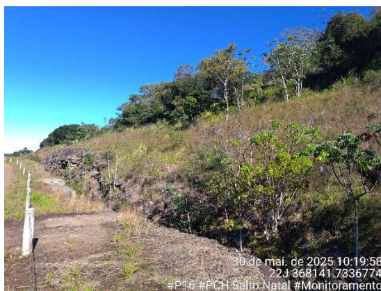
Figura 138 - Aspecto do ponto P16. Fonte: Cedro Inteligência Ambiental, maio/2025.
