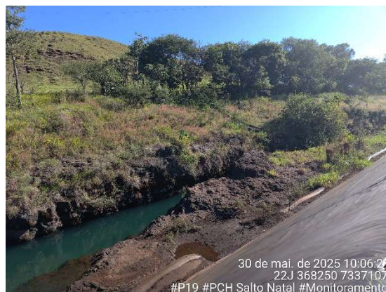
Figura 117 - Aspecto do ponto P19. Fonte: Cedro Inteligência Ambiental, maio/2025.
