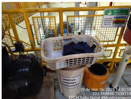
Figura 37 - Kit para derramamento de óleo na área de montagem. Fonte: Cedro Inteligência Ambiental, maio/2025.
