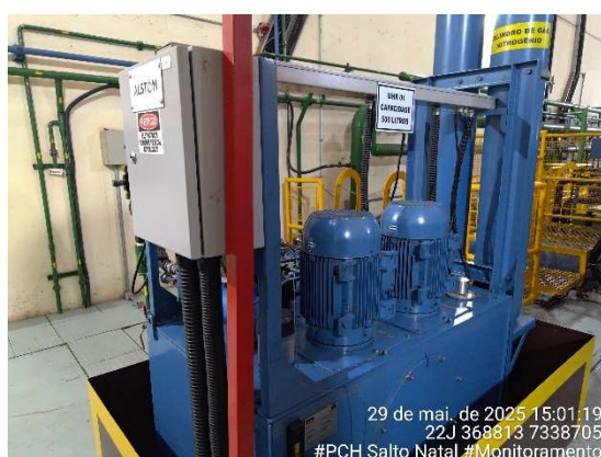
Figura 25 - UHR da Galeria Mecânica. Fonte: Cedro Inteligência Ambiental, maio/2025.
