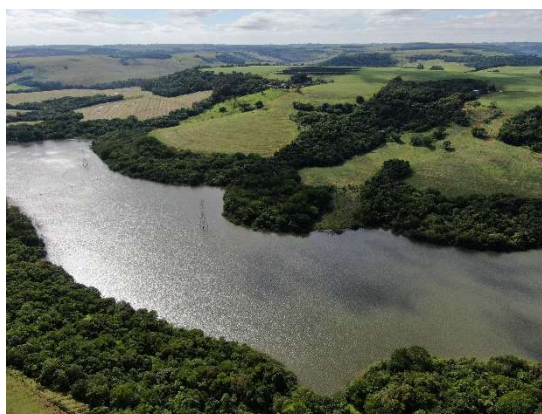
Figura 202 - Aspecto geral aéreo das áreas de APP do reservatório. Fonte: Cedro Inteligência Ambiental, nov./2025.
