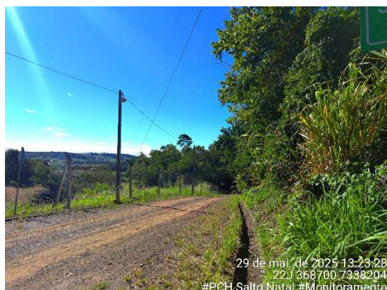
Figura 43 - Sistema de drenagem em ambos os lados da via de acesso. Fonte: Cedro Inteligência Ambiental, maio/2025.
